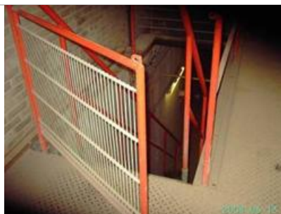
Opgaande kleiband afgeschermd met vast hekwerk
