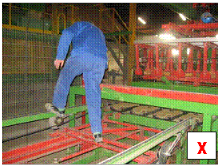
Eisen aan looppaden rond machine: valgevaar bij klimmen over dwarsomheffer
