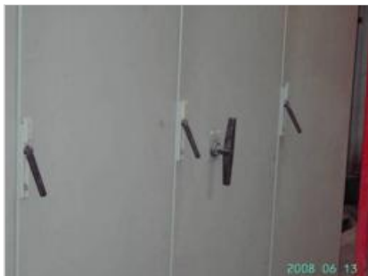
E-kasten bereikbaar voor onbevoegden
