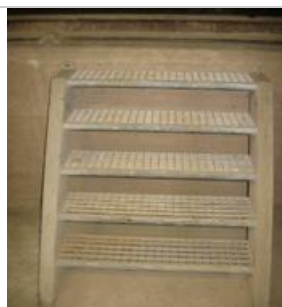
Gevaar van vallen trapje door ontbreken leuningwerk
