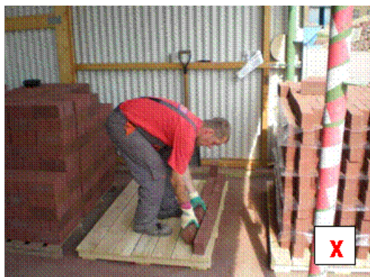
Foto: Pakket opbouwen voor machinaalbestratingmachine Ongunstige werkhouding
